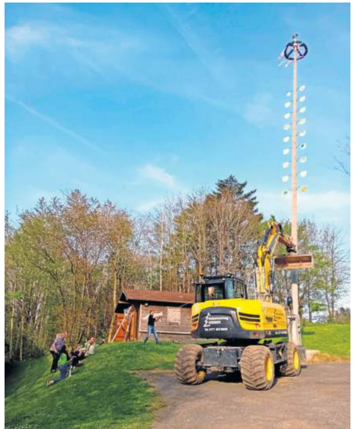
Maibaumaufstellen mit Baggerhilfe
